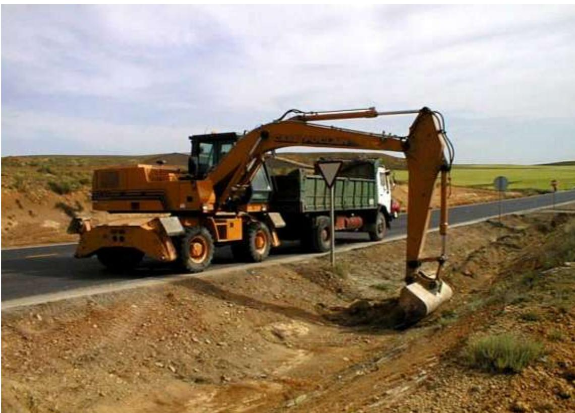
RETROEXCAVADORA GIRATORIA EN LIMPIEZA DE CUNETAS
