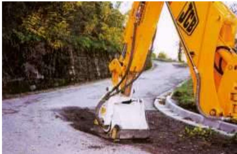
**FRESADORA INSTALADA EN BRAZO DE RETRO (a=400 mm)**
