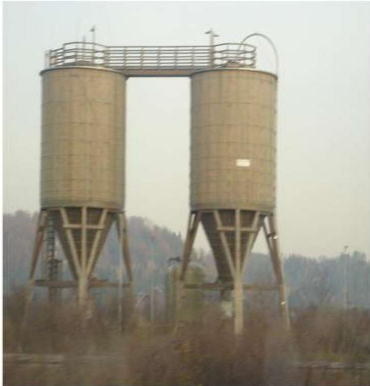
DOBLE SILO DE SAL CONSTRUIDO EN MADERA (ABSORBE LA HUMEDAD DE LA SAL) Y ACERO INOXIDABLE.
