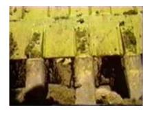
Ahora tire de la palanca y mantenga el movimiento constante de retracción del brazo, esto acercará el brazo a la posición vertical, recuerde la dureza del material determina el largo y la profundidad del pase, a medida que se retrae el brazo, levante ligeramente la pluma este movimiento hacia arriba de la pluma evitará que se detenga
